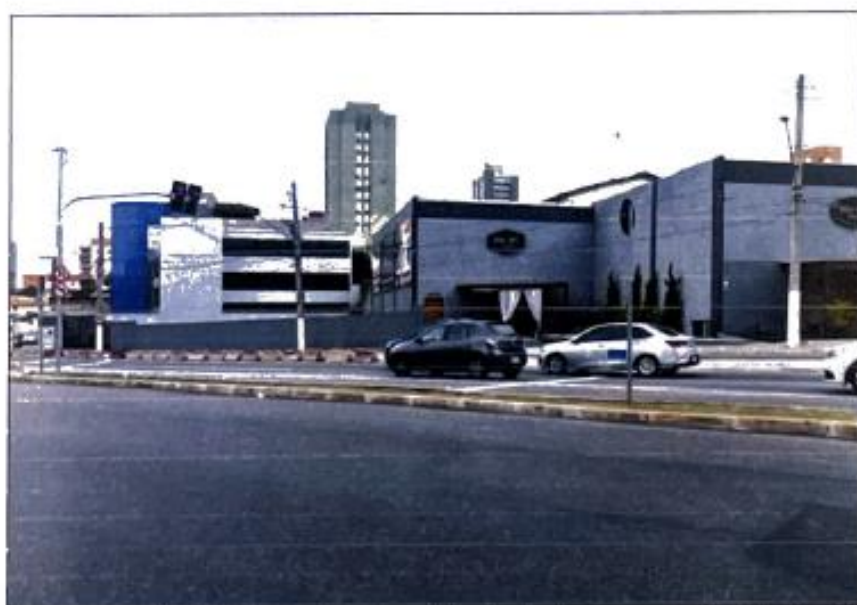
De um ponto da Av. Newton Monteiro de Andrade observa-se a divisa da área "D" com a empresa de eventos que anteriormente a utilizava como estacionamento.
